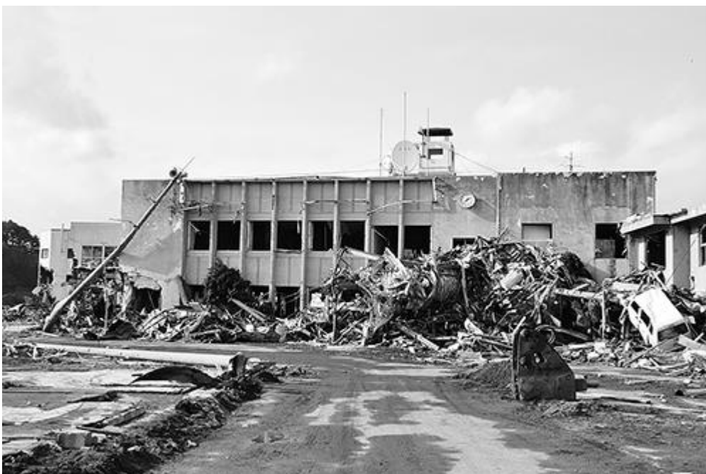
東日本大震災で被災した岩手県大槌町役場
