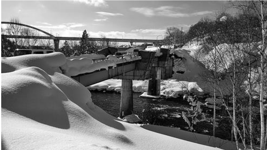
雪のなか、修繕工事中の芙蓉橋(ニセコ町尻別川)
