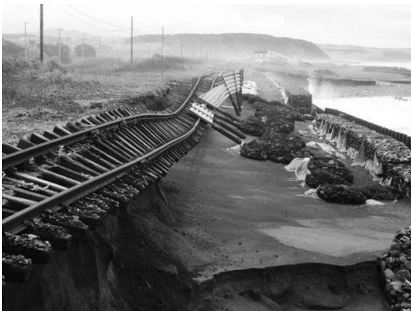
▲©JR 北海道 JR 日高線清島・豊郷間—高波で破壊された線路—(すぐ右側が海岸線)
