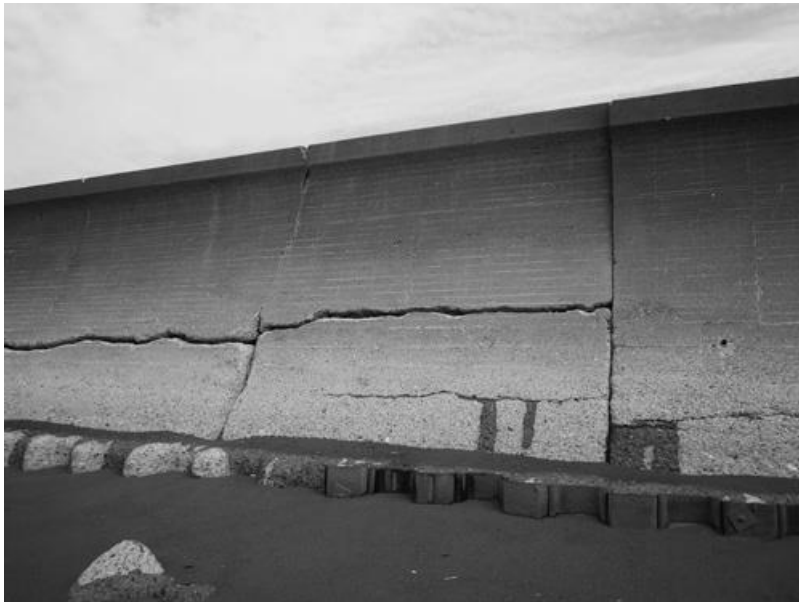
亀裂の入った防波堤(海側から静内地方自動車整備協同組合理事長撮影)
