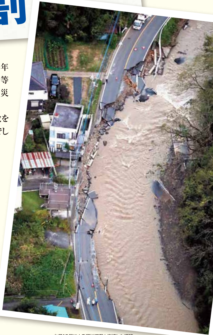
台風19号による河川氾濫と崩壊した道路。 19年10月13日 東京都日の出町(朝日新聞社/時事通信フォト)
