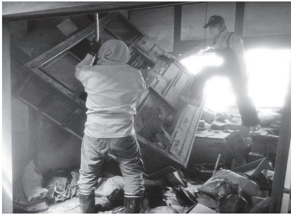
片付け作業中の様子
