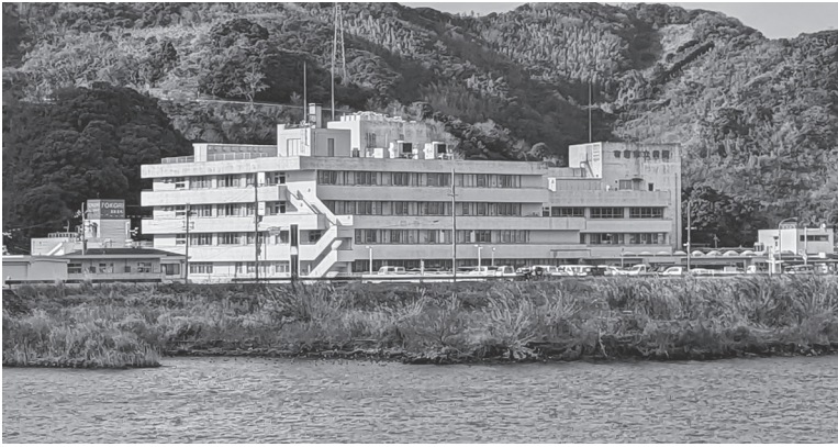
移転新築する有田市立病院
