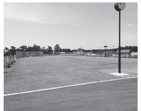
新浜地区につくられた避難高台
