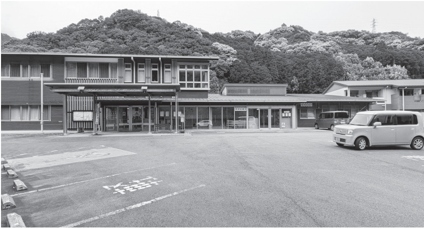
保健福祉センター、明神診療所、右は町営住宅（川口地区）
